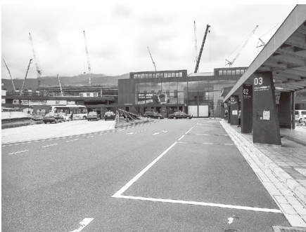
敦賀駅正面からの新幹線の工事現場写真（7月現在）
