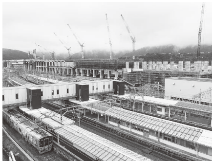
上からの新幹線の工事現場写真（6月末現在）
